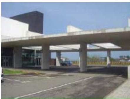
Foto 1. Marquesina de acceso a una UUH
